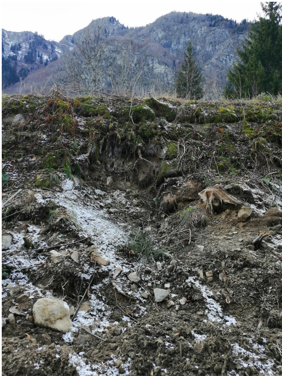
Figura 14 – Buca da impatto di un blocco sul rilevato preesistente. Foto scattata durante il sopralluogo del 03 dicembre 2021
