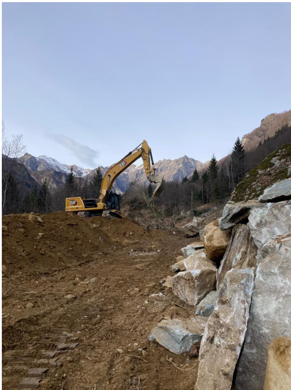
Figura 15 – Lavori per la pulizia e sistemazione dell'area di frana e realizzazione del nuovo rilevato in somma urgenza. Foto scattata durante il sopralluogo del 03 dicembre 2021
